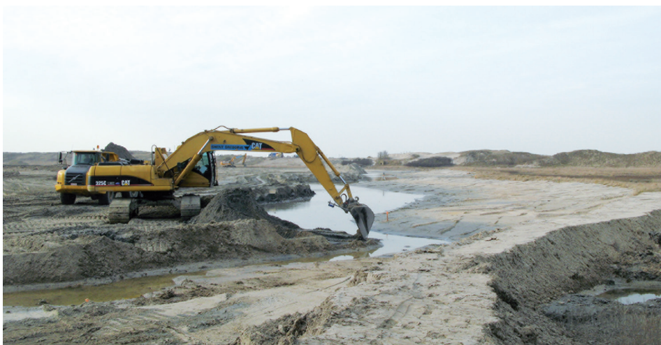
■ De aanleg van ongeveer vier kilometer zeeverende dijk vergt ingrijpende grondwerken en een aanzienlijk grondverzet (ANB)
