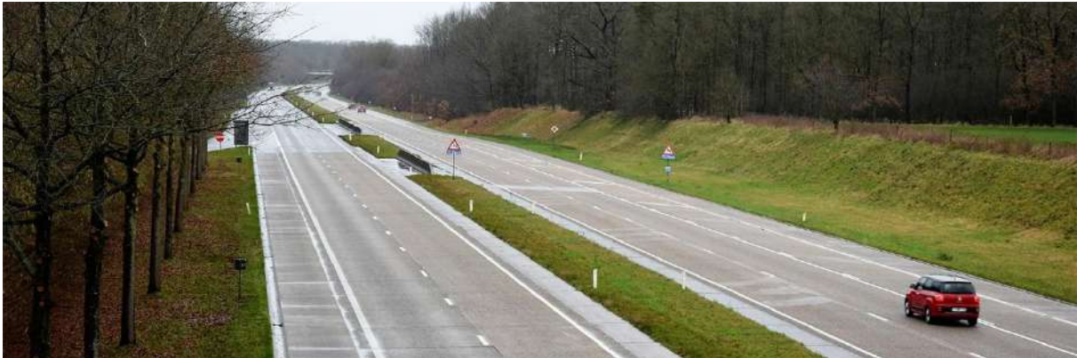
Gewestwegen zoals de N74 Noord-Zuidverbinding vormen barrières in Nationaal Park Bosland
