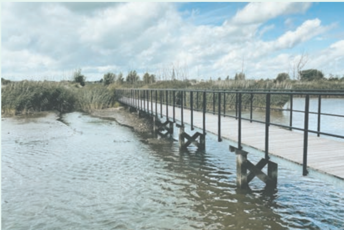
brug wandelaars en fietsers
