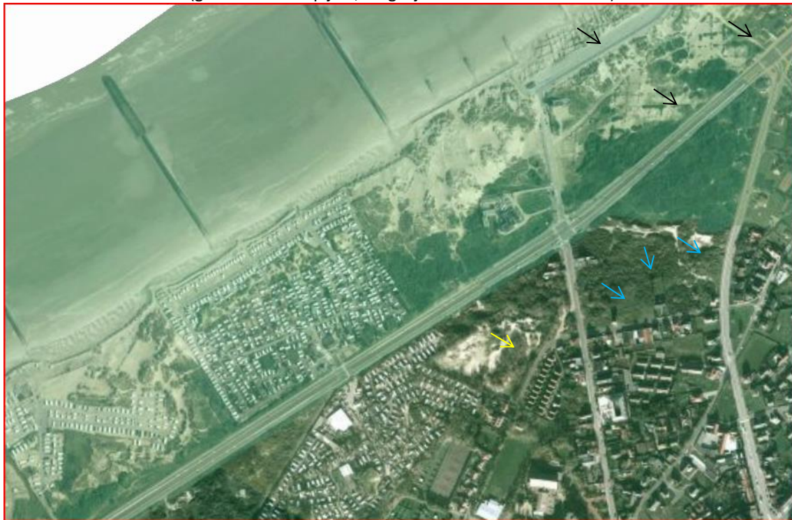
Fig.4.1.42. Luchtfoto 2000-2003 . Het duingebied wordt nog steeds intensief als camping gebruikt. In het noordoostelijk deel van de Sint-Laureinsduinen zijn rijshouten constructies aangebracht om de duinen te stabiliseren (zwarte pijl). De relictten ervan zijn tegenwoordig nog tastbaar aanwezig als (ongewenste) wilgen en populierenopslag. Ten zuiden van de Koninklijke Baan zijn aanzienlijke stukken van de duinen verder verstruweeld of verbost (gele en blauwe pijlen, vergelijk ook met luchtfoto 1971).
