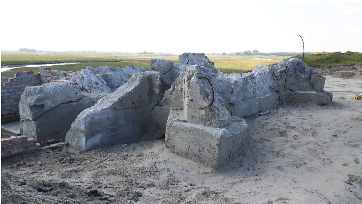
Fig. 45. De bunker zoals deze werd aangetroffen.
