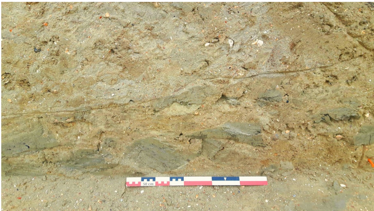
Fig. 226. Tussen het zand aanwezige kleiplaggen in één van de onderste lagen van de dijk (L10).
