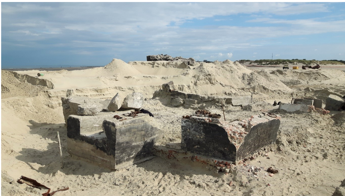
Fig. 57. De westelijke toegang en achterzijde van de bunker met bakstenen aanbouw.
