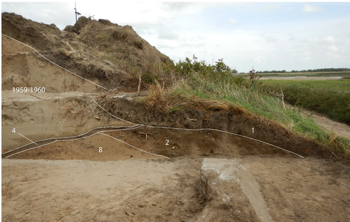
Fig. 223. De top van de dijk uit 1872-1873. Vooraan is een deel van de bunker al zichtbaar.
