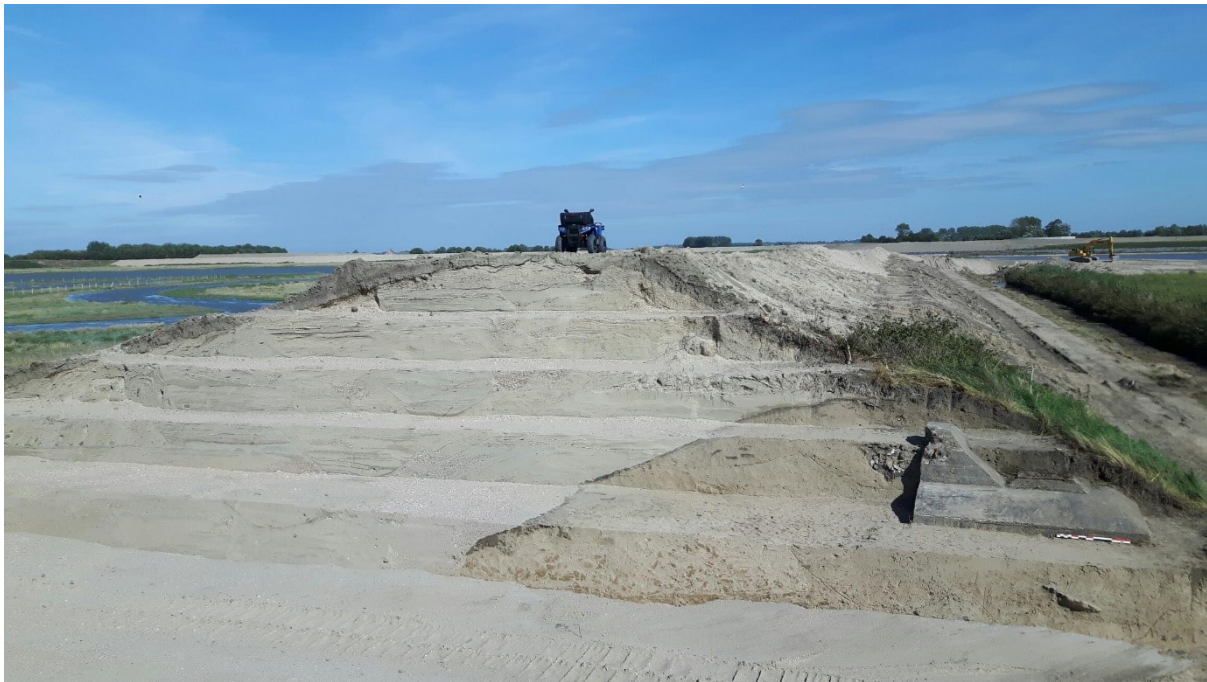
Fig. 83. Rechts de oudste fase van de Internationale dijk, met de bunker deels zichtbaar.
