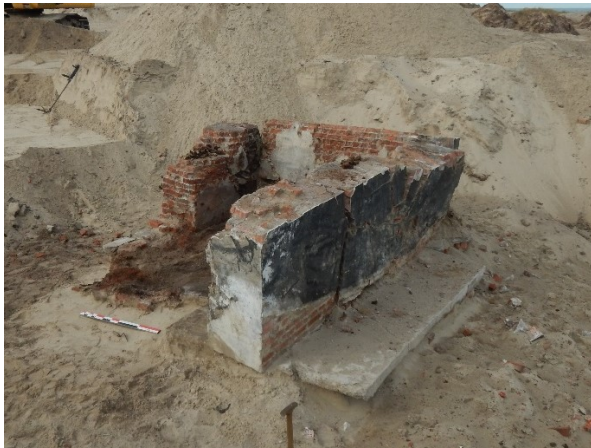
Fig. 125. BSB09 is gefundeerd op een betonnen plaat.
