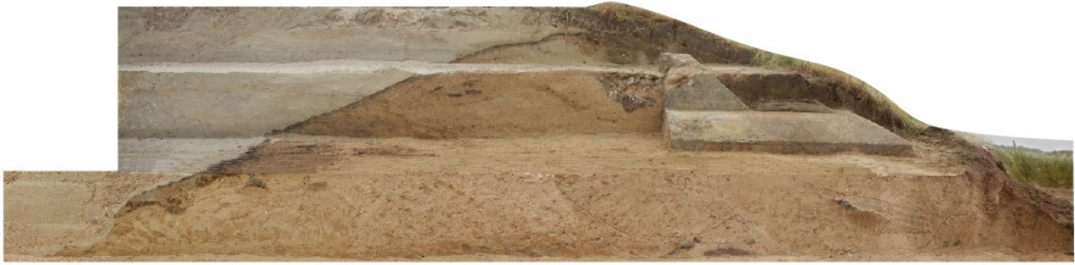
Fig. 229. Fotogrammetriefoto van de oude fase van de dijk, met uitzondering van trap 4 en de profielput.
