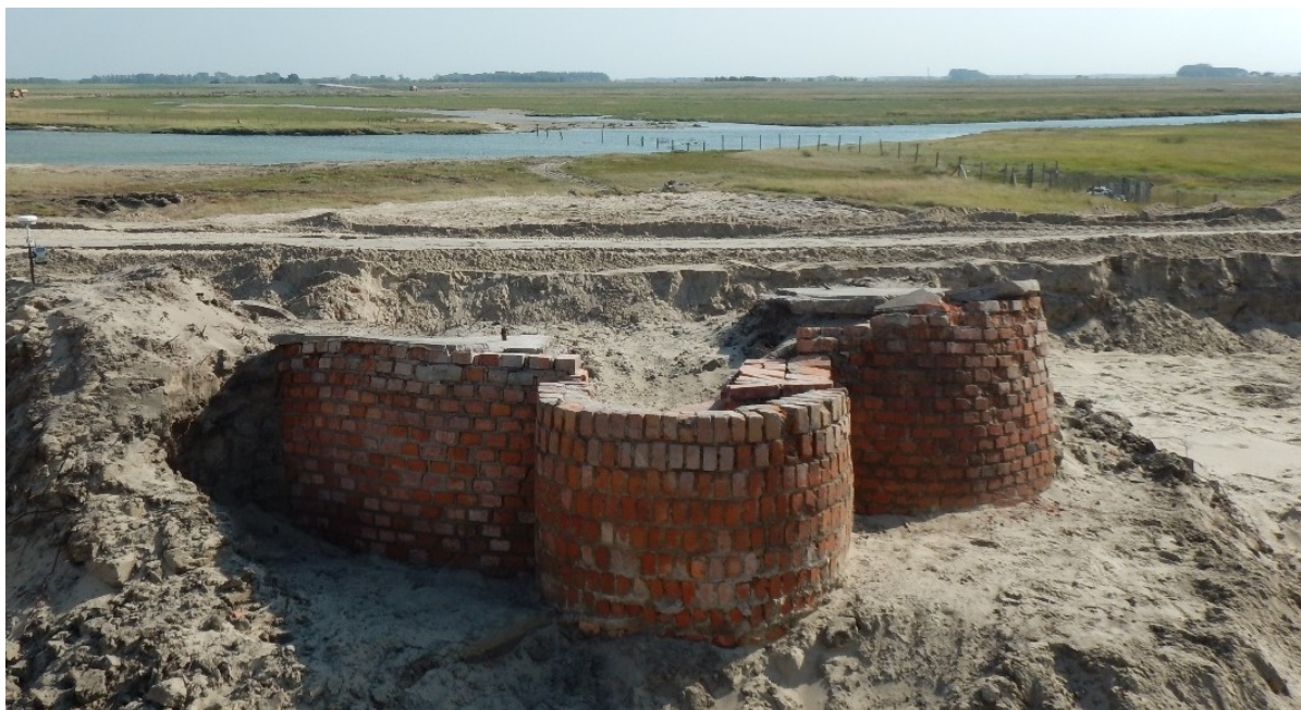
Fig. 97. Baksteenbouw BSB04, met flankerende platformen (PLA02).
