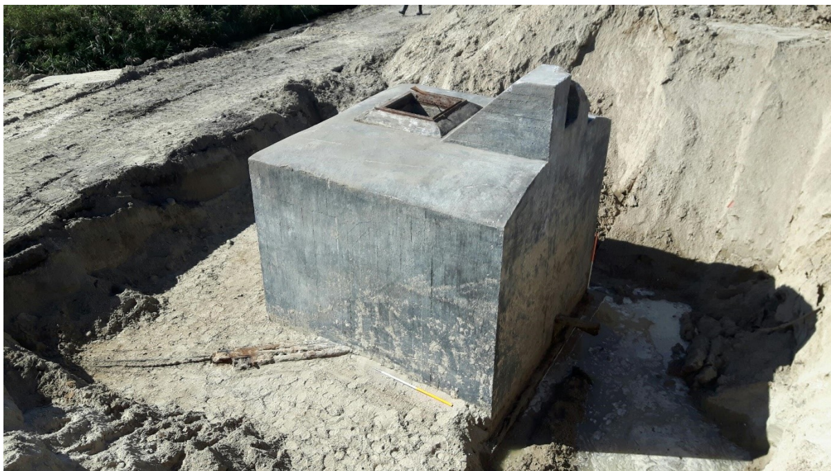
Fig. 84. De vrijgelegde bunker, met duidelijk zichtbaar toekomende telefoonkabels.
