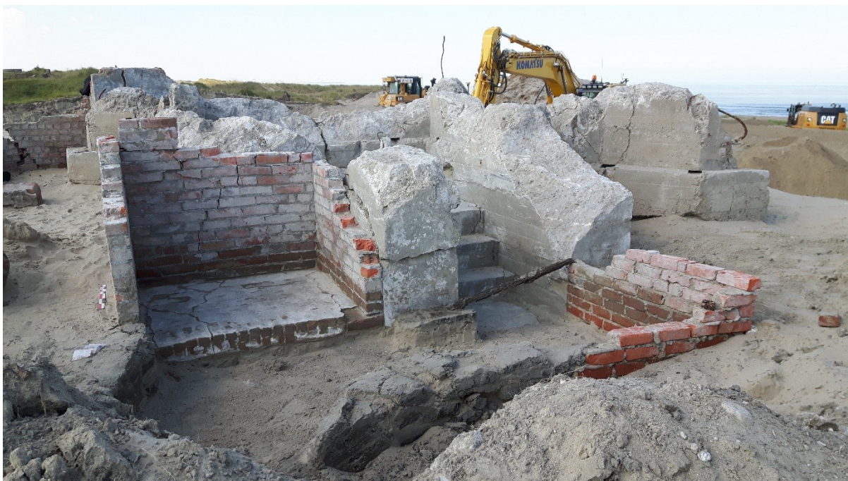
Fig. 46. De ingang van de bunker met aansluiting op het loopgraaf. Links het bakstenen structuurtje BSB01.
