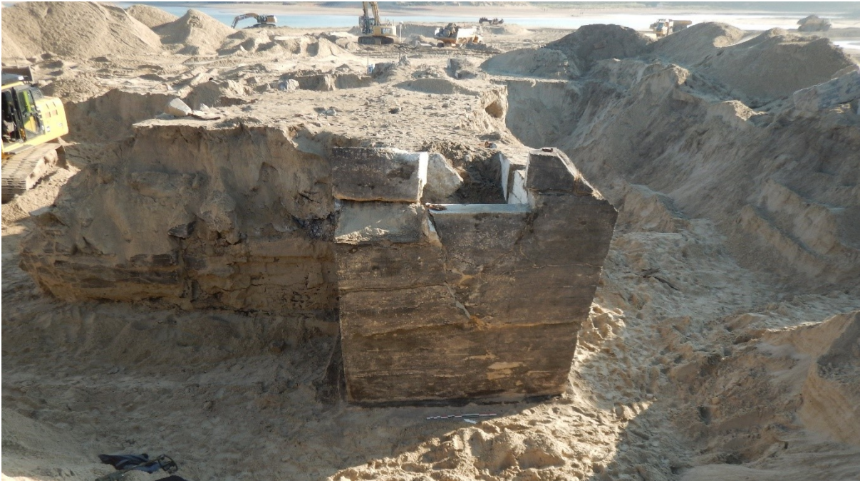
Fig. 232. Ingang BNR06. Deze ingang zit bovenaan in de uitgebouwde toegang. Via een betonnen trap daalde men af in de bunker.
