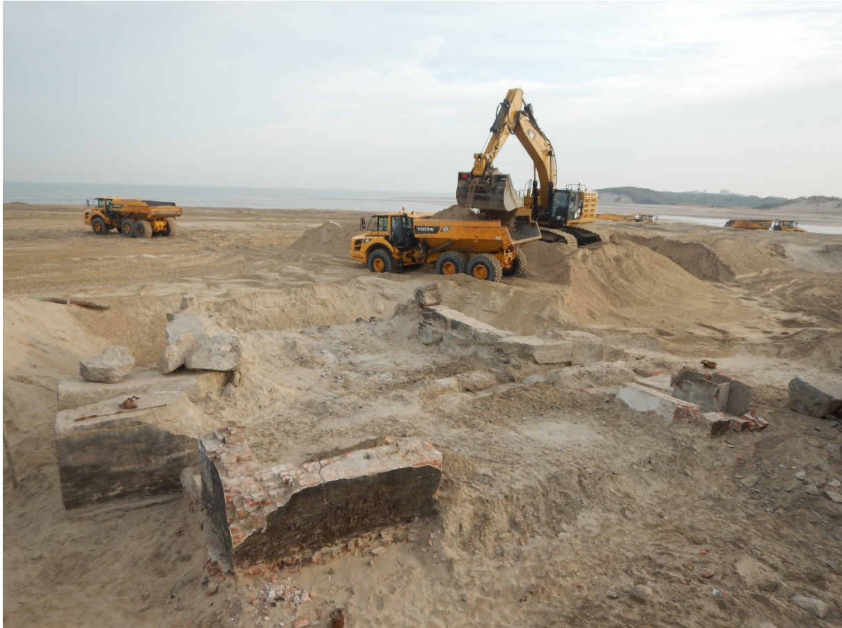
Fig. 123. Bunker BNR07 met een deel van de achterbouw.
