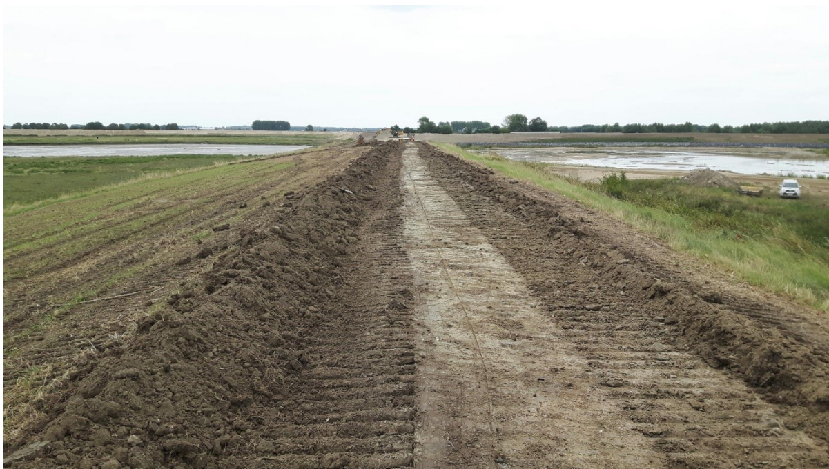
Fig. 217. De Internationale Dijk twee weken voor aanvang van het archeologisch onderzoek (links zeezijde, rechts landzijde).
