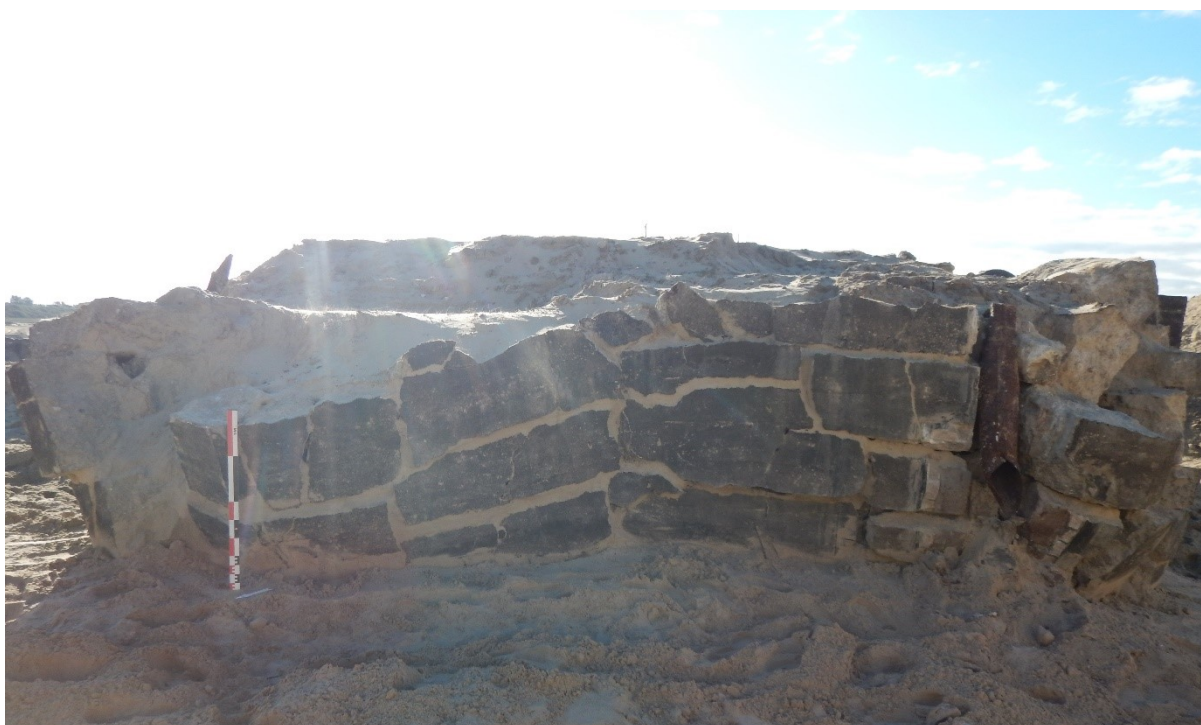
Fig. 68. De noordwestelijke zijde. Rechts is een verluchtingsschacht met een ijzeren buis te zien.
