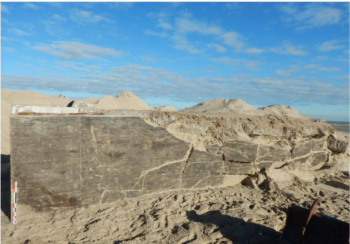
Fig. 70. De achterzijde van de bunker.
