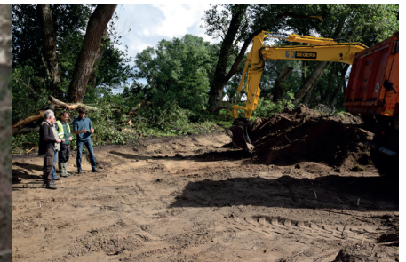
Afgraving van de bovenste bodemlaag van een voormalige akker om een vochtige duinpan te herstellen in de Oostvoorduinen (België) ©Marc Leten
