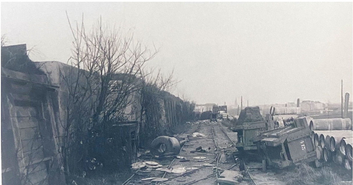
Batterij Herta in de Eerste Wereldoorlog, op de linkeroever van de haven van Blankenberge. Uit: DESEYNE, A., 2005. De Kust bezet: 1914-1918. Brugge: Provincie West-Vlaanderen.
