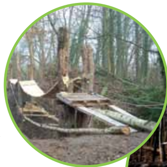
avontuurlijke hangbrug: in opbouw en afgewerkt (foto rechts: Stad Aalst)
